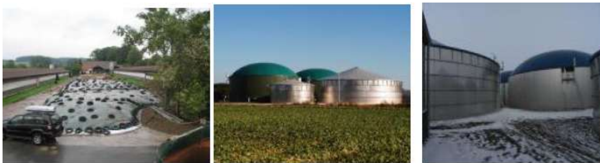
Фиг. 10.7. Платформа за съхранение на силаж и ферментационна група
